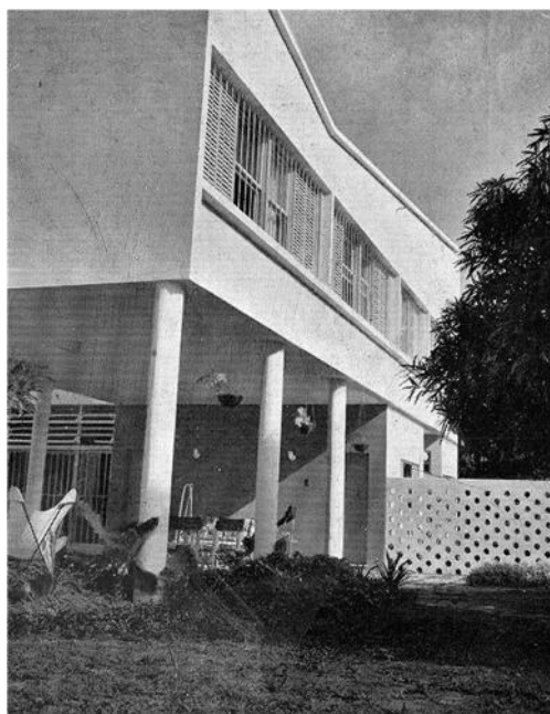
Figura 13: Fachada posterior da residência. Fonte: FERNANDES, 1955c.
