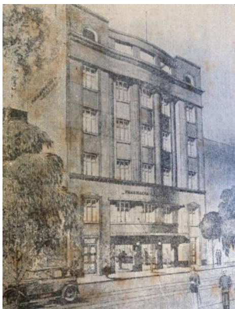
Figura 2: Farmácia Caldas – fachada Fonte: Diário de Notícias (13/02/1932, s/p)
