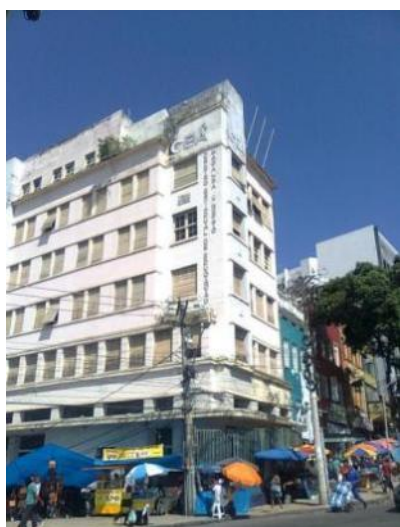
Figura 15: Edifício do Saneamento Fonte: Ana Carolina Bierrenbach, 2013
