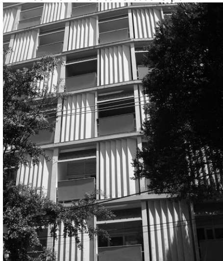
FIGURA 9: Edifício Comendador Uripia
