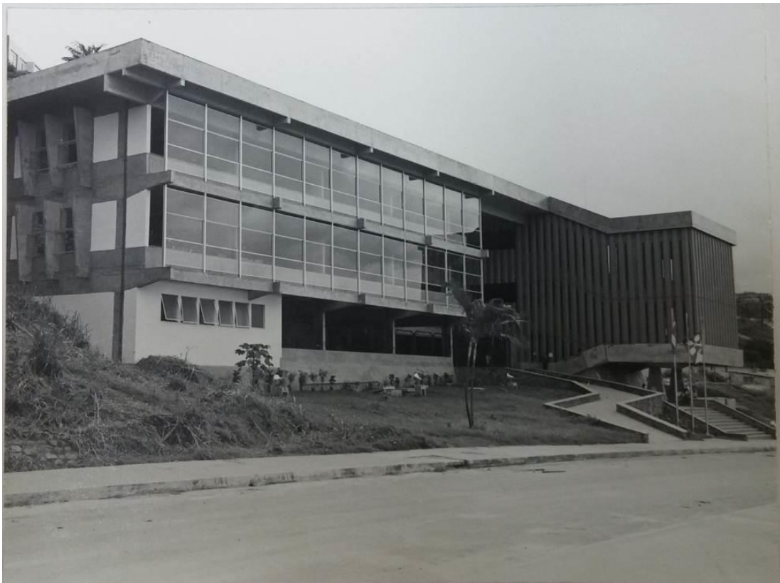
Figura 10 – Vista externa RU, década de 80. Fotografia de Mário Mendonça. Fonte: Acervo SUMAI.
