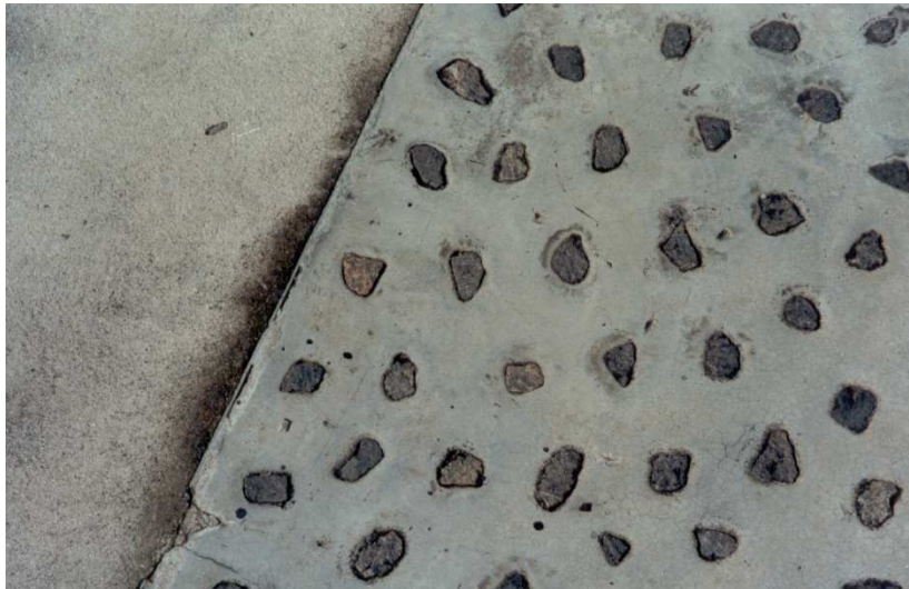
Figura 8 – detalhe da solução anterior do chão da Barroquinha: embrechamento de brita em piso de cimento Fonte – Eduardo Rossetti, 2001
